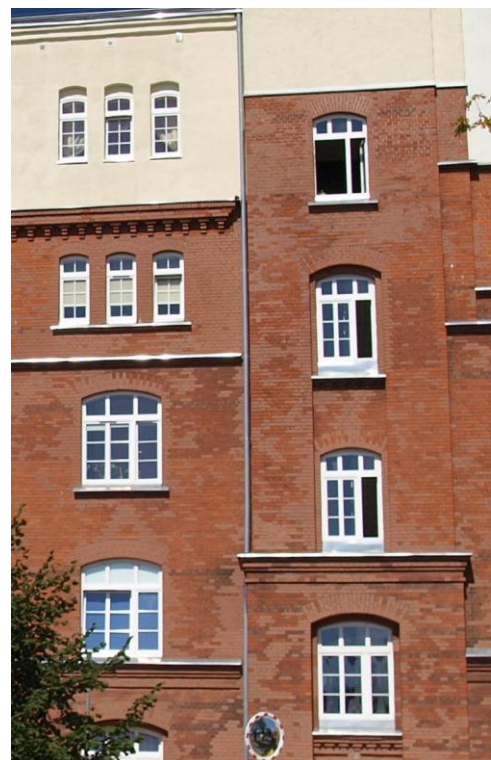
Otwory okienne skrzydła wschodniego
