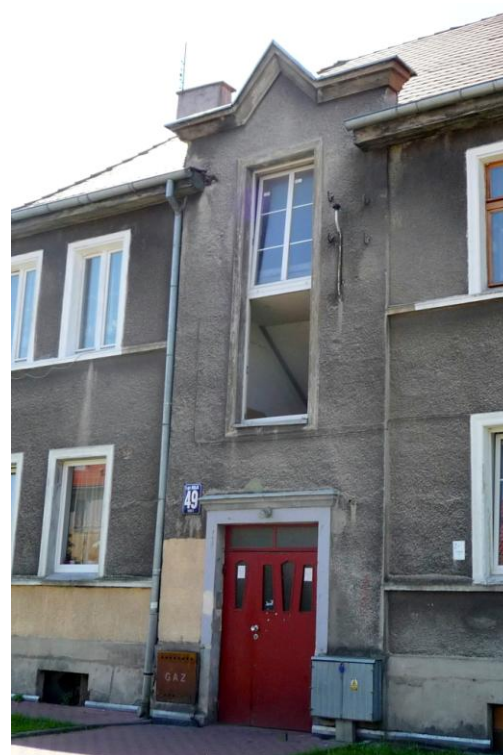
Część elewacji północno-wschodniej
