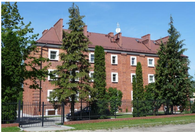
Widok budynku od południowo-wschodu
