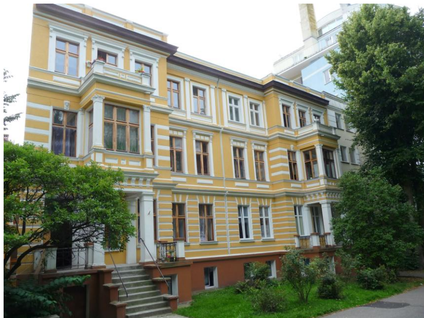
Widok budynku od północnego-wschodu
