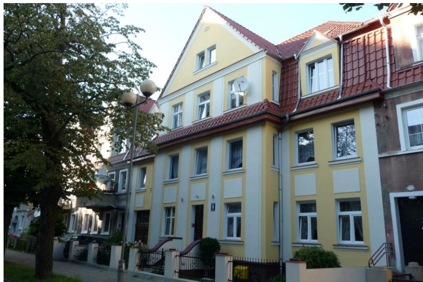
Widok budynku od południowego-zachodu
