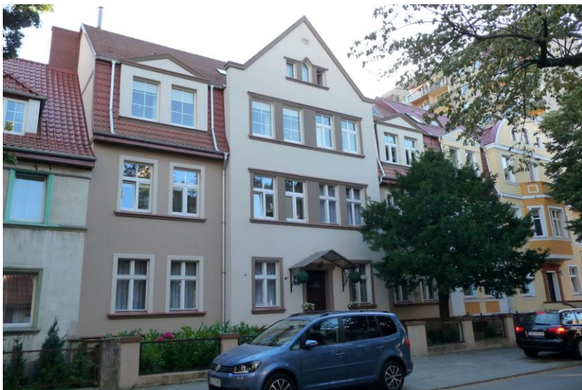
Widok budynku od północnego-wschodu
