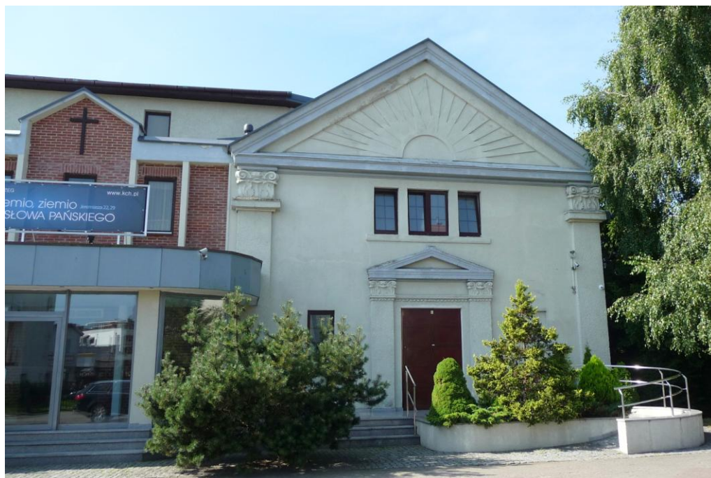
Widok budynku od północnego-wschodu
