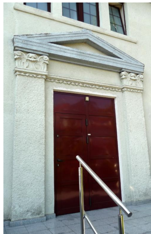
Portal drzwiowy w elewacji północno-wschodniej
