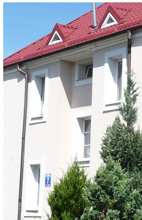
Część elewacji południowo-zachodniej
