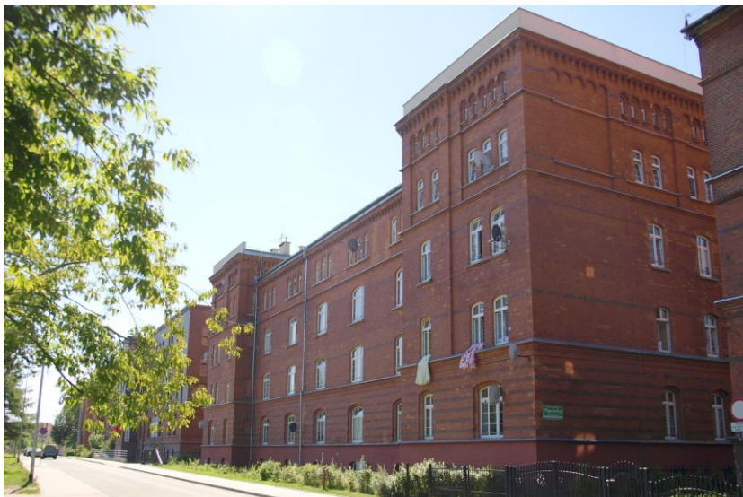
Widok budynku od północnego-wschodu
