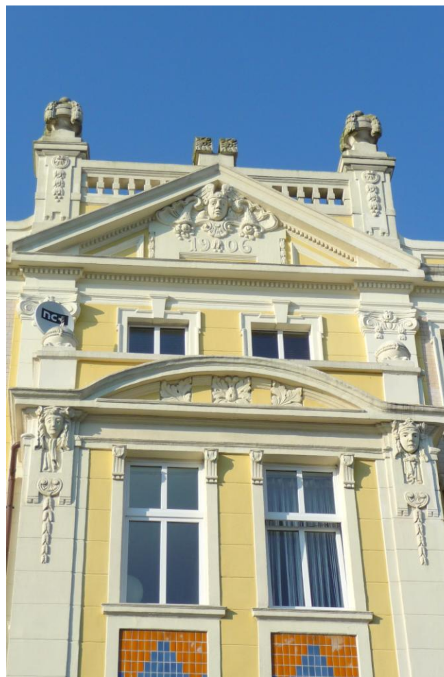
Balkon w elewacji południowo-zachodniej
