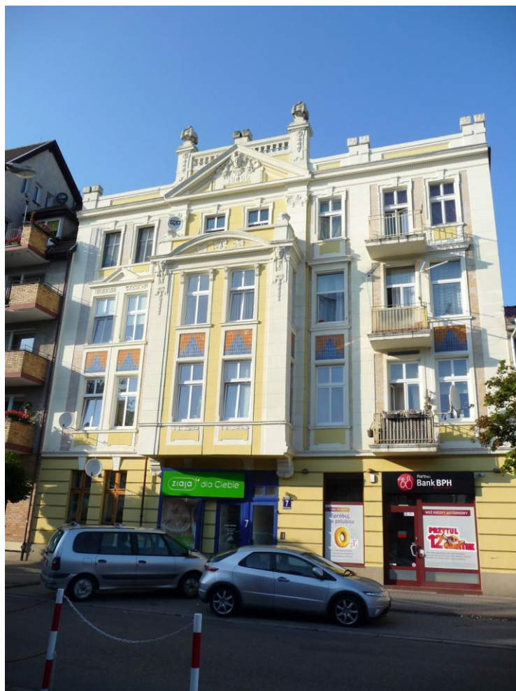
Widok budynku od południowego-zachodu
