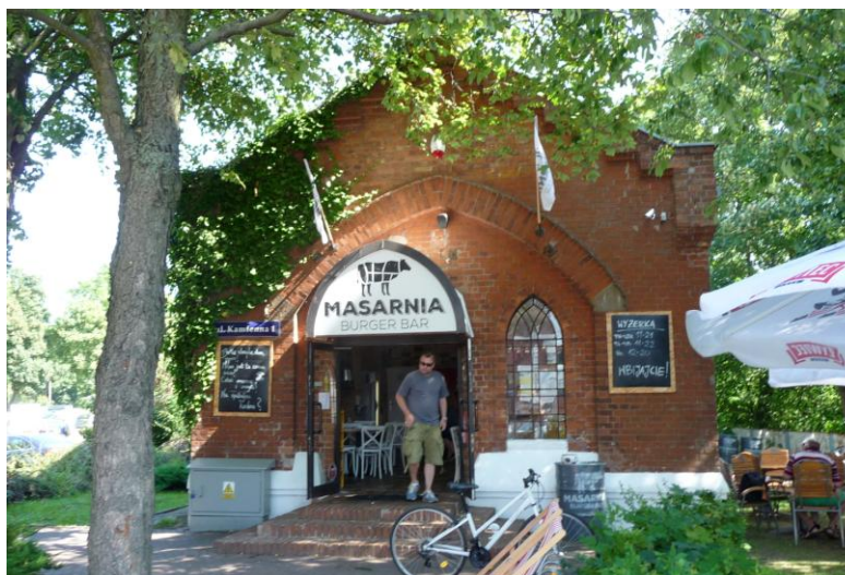
Widok budynku od północno-zachodu
