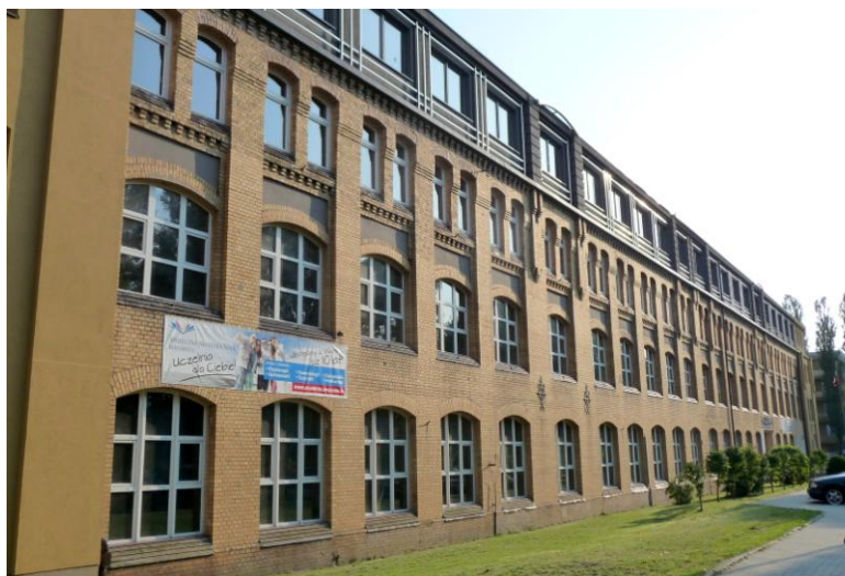
Widok budynku od północy
