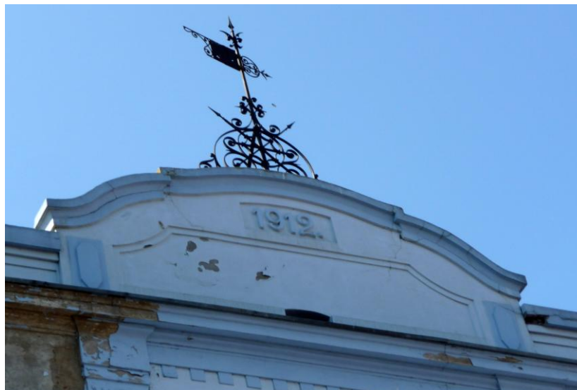
Murek attykowy w elewacji południowo-wschodniej
