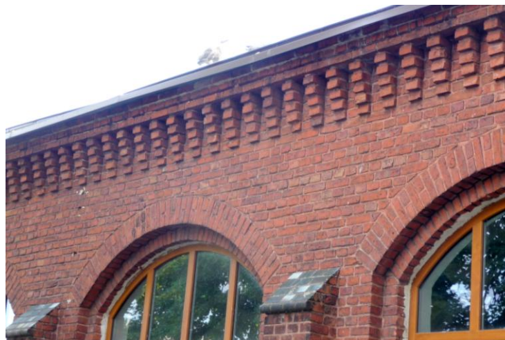
Fragment elewacji południowej
