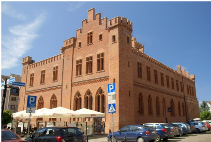
Widok budynku od wschodu
