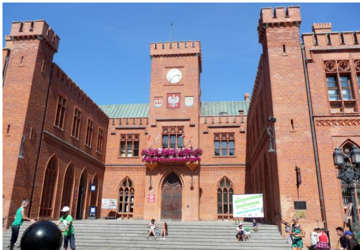
Widok budynku od południowego-zachodu
