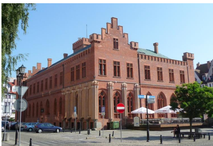
Widok budynku od północy
