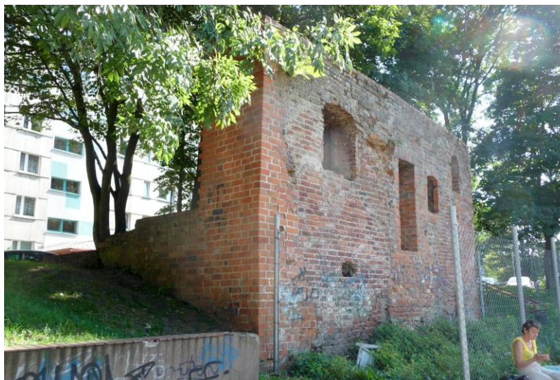
Widok budynku od północy
