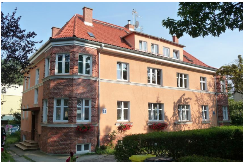
Widok budynku od północnego-zachodu
