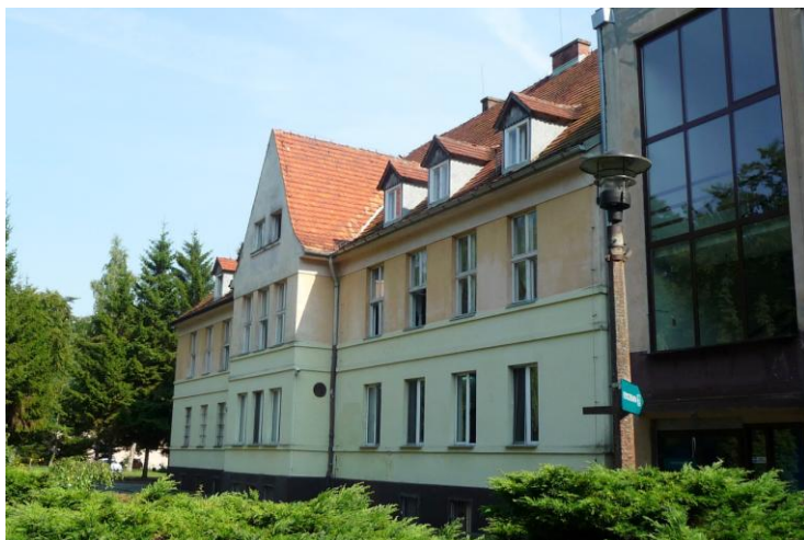
Budynek północny, widok od północy
