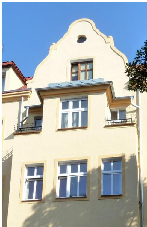
Ryzalit elewacji północno-zachodniej
