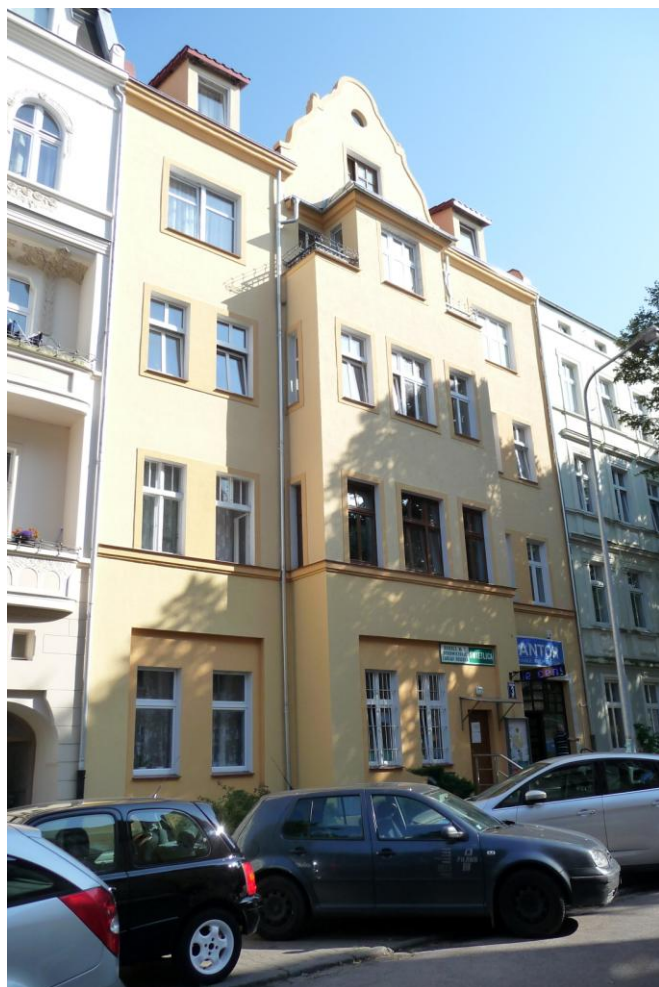
Widok budynku od północno-zachodu
