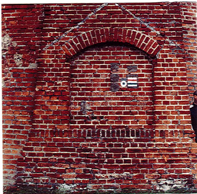
4. Detal zamurowanego przejścia w murze oporowym Fortu Ujście, neg. 1400/57/3
