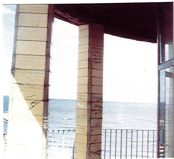
6. Żelbetowe słupy podtrzymujące latarnię, neg. 1400/55/3
