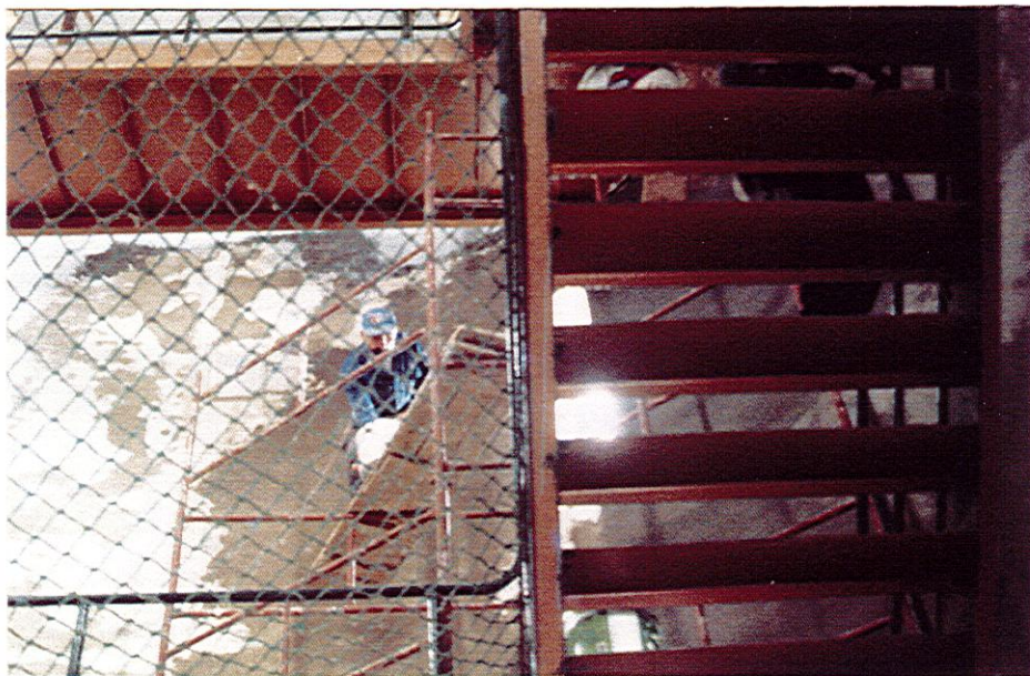
4. Stalowe schody komunikacyjne w trzonie wieży latarni morskiej, neg. 1400/53/5
