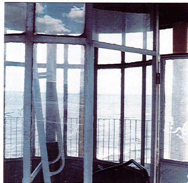
6. Drabina wejścia z tarasu wieży na latarnię, neg. 1400/55/4
