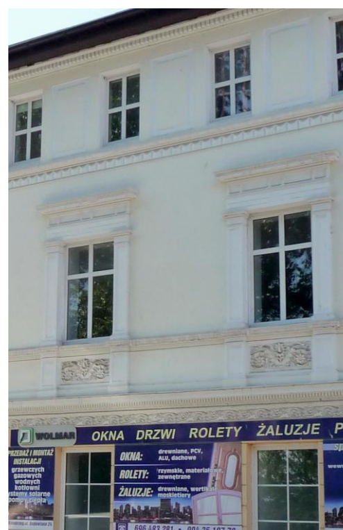
Otwory okienne w elewacji południowo-wschodniej
