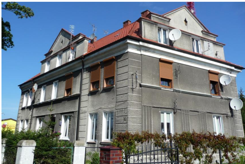
Widok budynku od południowego-wschodu
