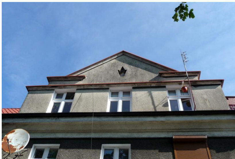
Facjata w południowej połaci dachu
